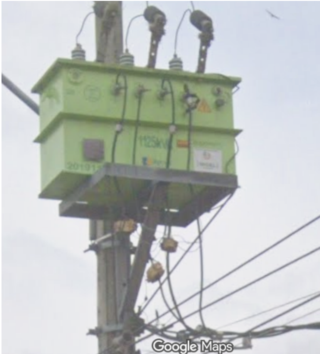
Figura 1: Transformador de 112,5 kVA (13,2 kV / 220 V) de la Plaza de Mercado “La Concordia”.
