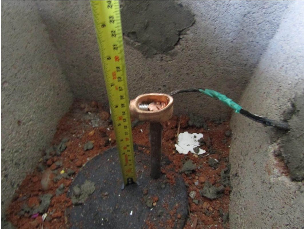
Figura 3: Detalle interno de la caja de inspección y acceso a la varilla.
