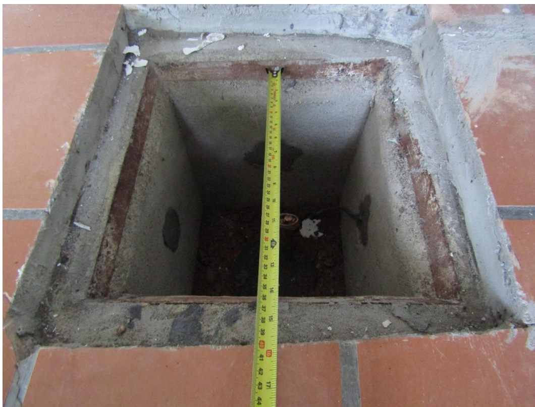
Figura 2: Vista general de la caja de inspección existente.
